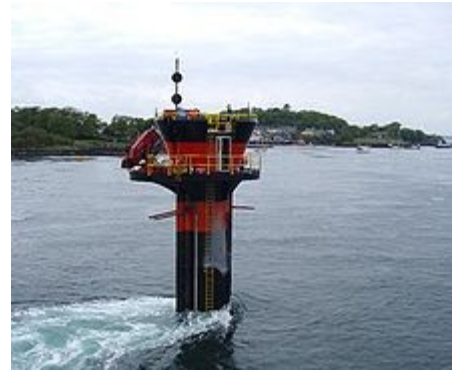
位於斯特兰福德湖的世界上第一个商业规模的并网潮汐流发电机-SeaGen。[3]明显的尾流显示出潮汐流的力量。
